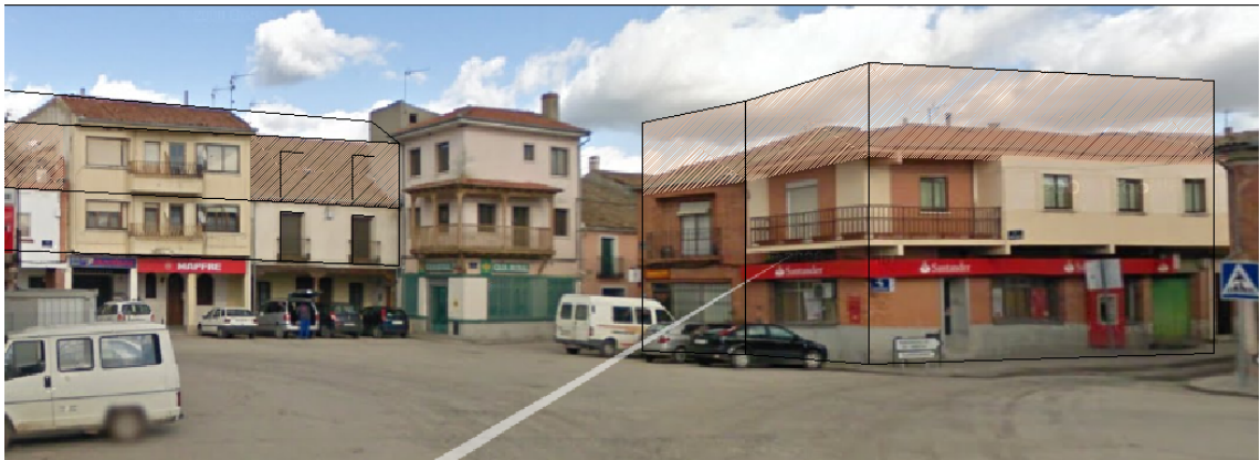
Alzado norte plaza de la Fuente parcelas 15, 16, 17 y 18 manzana 69474 y parcelas 1 y 13 de la manzana 69465
